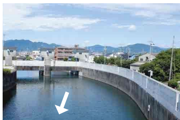
対策後の河口～浜川水門
