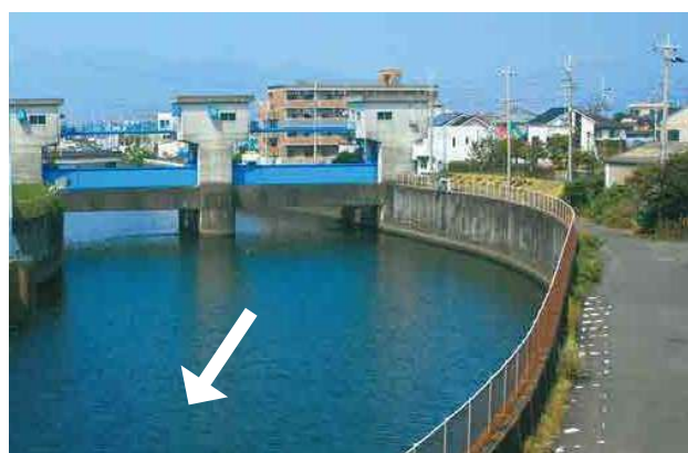
対策前の河口～浜川水門
