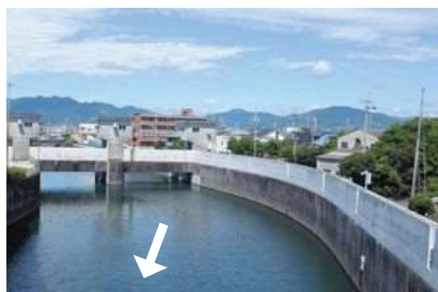
対策後の河口～浜川水門
