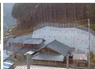
施工後（葵区渡寺山内）
