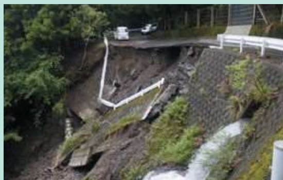
(主) 南アルプス公園線 (大間)
