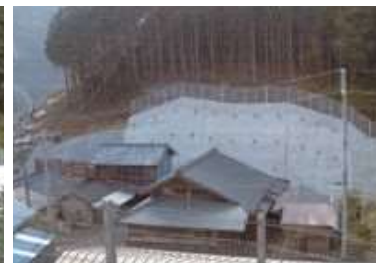
施工後（葵区渡寺山内）
