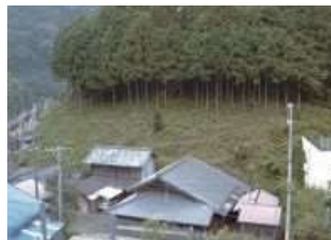
施工前（葵区渡寺山内）
