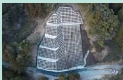
R5.2 工事完成
