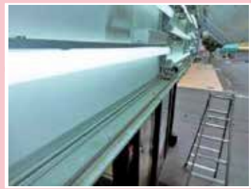
不良箇所 無し
