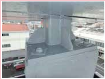
不良箇所 無し
