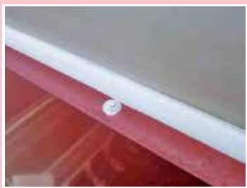
不良箇所 無し
