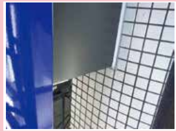
不良箇所 無し
