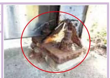
アンカーボルトが腐食している状態
