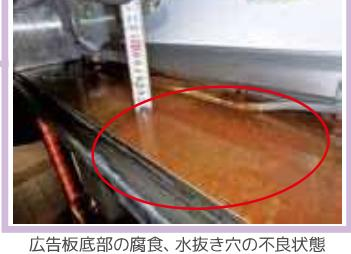
広告板底部の腐食、水抜き穴の不良状態
