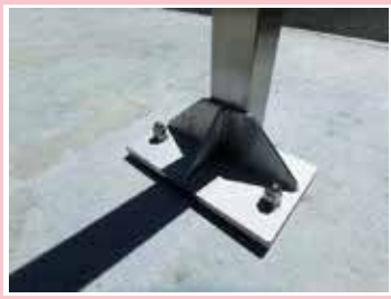
不良箇所 無し
