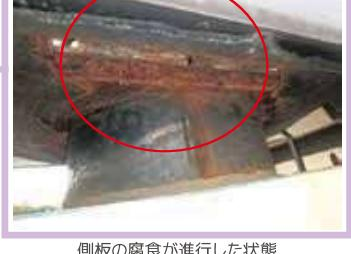
側板の腐食が進行した状態
