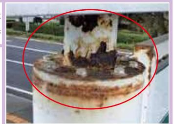
鉄骨接合部が腐食進行している状態
