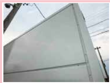
不良箇所 無し
