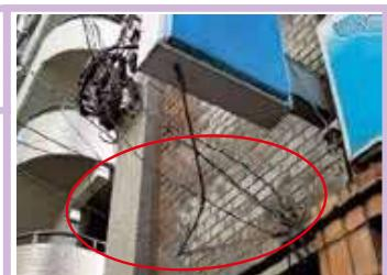
幕材を張る部材が破損した状態
