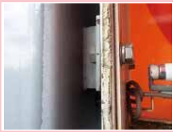
不良箇所 無し
