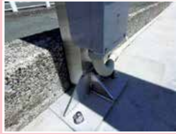
不良箇所無し
