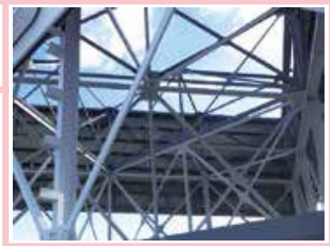
不良箇所無し
