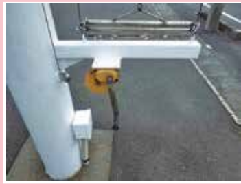
不良箇所無し
