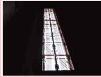
不良箇所無し
