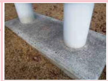
不良箇所無し
