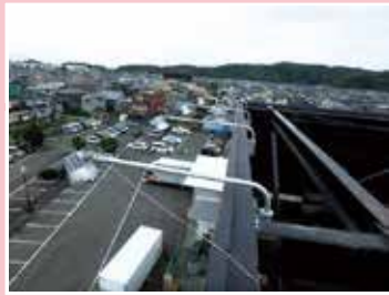
不良箇所無し
