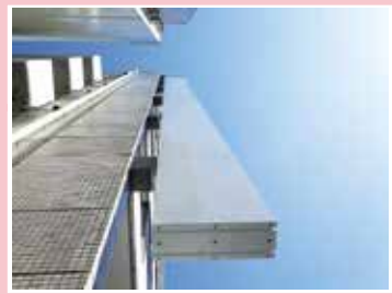
不良箇所 無し
