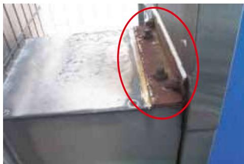
接合部のアングル、ボルトナットの腐食が進行した状態→
