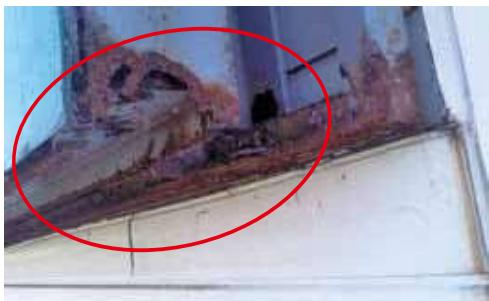
底部の腐食が進行している状態
