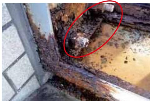
アンカーボルトの腐食が進行した状態
