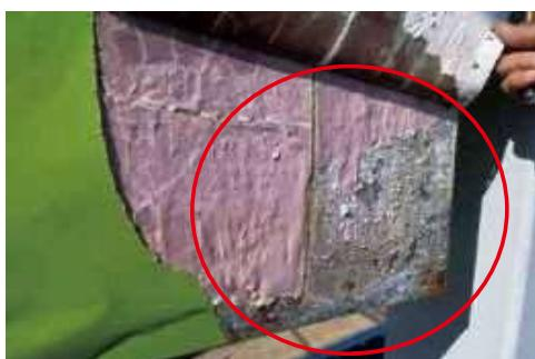
表示フィルム裏面に滯水し、面板が劣化した状態→滯水原因の調査と結果に応じた対処が必要
