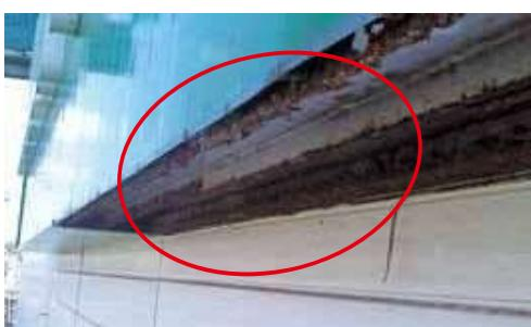
鉄骨の腐食により、側板底部が脱落した状態
