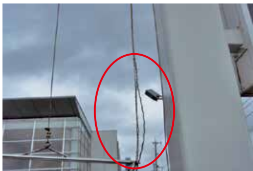
懸垂幕用ワイヤが破断している状態 →ワイヤの取替えが必要
