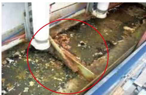
苔・鏽により水抜き穴がふさがった状態
