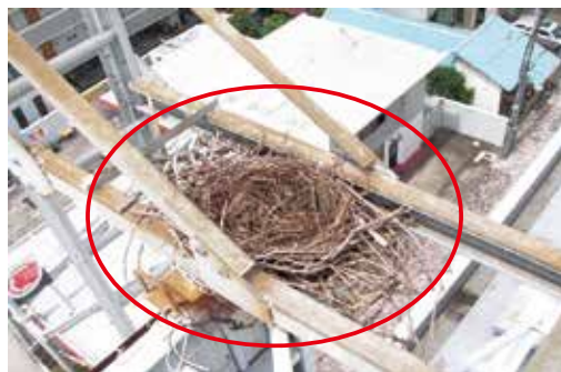
メンテナンス用タラップに野鳥が営巣した状態→巣に卵や ヒナが居なければ撤去する
