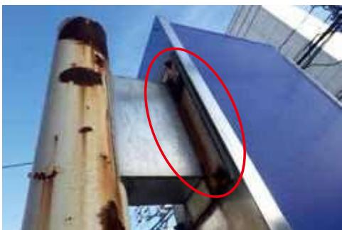
プレートの腐食が進行し、劣化した状態
