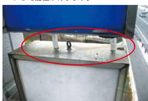
劣化により、側板底部及びランプが外れている状態
