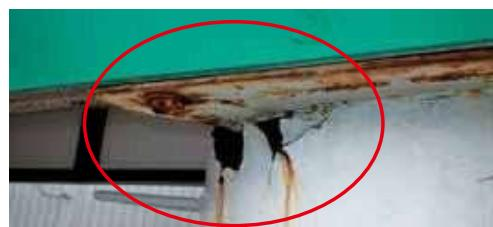
支柱・接合部付近が腐食している状態
