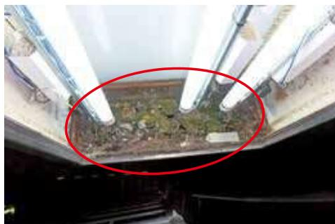
苔・錆により、水抜き穴が塞がった状態
