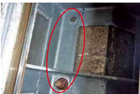
アンカーボルトの欠損及び腐食により劣化した状態→新規ボルトナットの取付、取替えが必要
