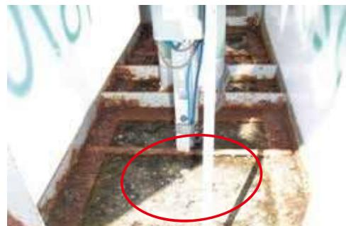
苔・錆により、水抜き穴が塞がった状態
