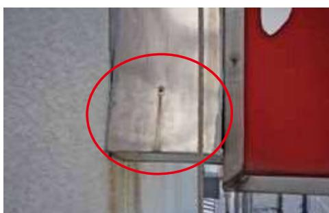
リベットの破断によるカバーのぐらつき
