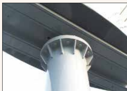
支柱・広告板接合部
