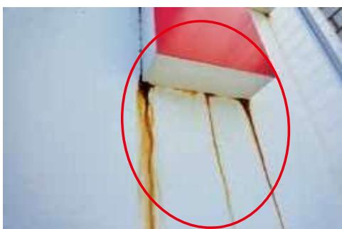
凸文字内部が腐食し、表面が変色した状態
