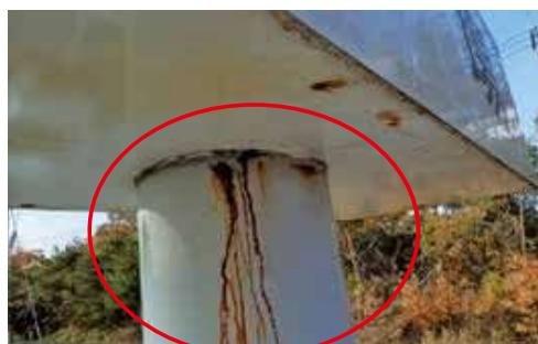
看板底部の腐食により、支柱に錆だれがある状況→看板内部の確認が必要
