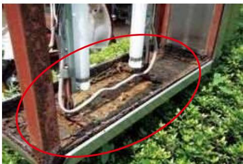
水抜き穴が無く、滯水により腐食が進行した状態→水抜き穴開けが必要
