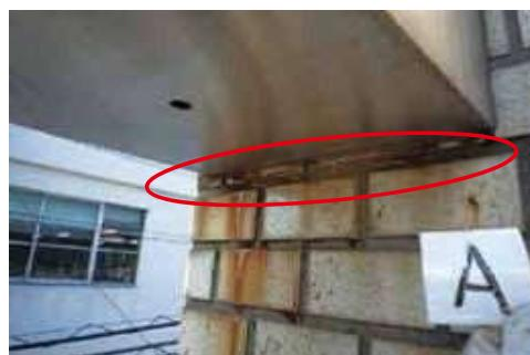
ブラケットの腐食により、外壁が汚損されている状態
