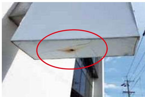
内部の腐食により水抜き穴周りが変色した状態→腐食状況の確認が必要
