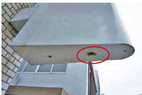
看板底部の腐食により、穴があいた状態
