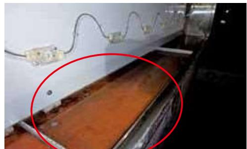
看板底部の滯水による腐食進行している状態
