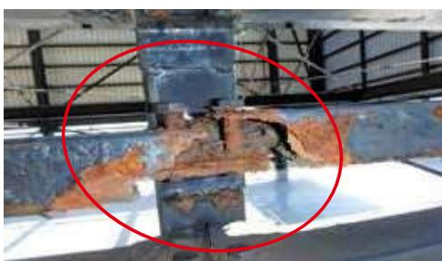
腐食の進行により、接合部が欠損した状態
