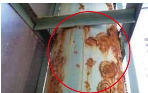
支柱の腐食が進行し、劣化している状態
