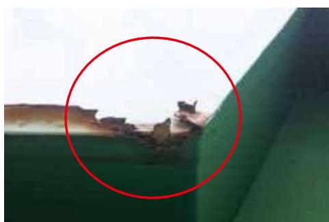
面板押さえが腐食により欠損した状態
