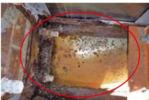
ブラケットの腐食が進行し、劣化した状態
