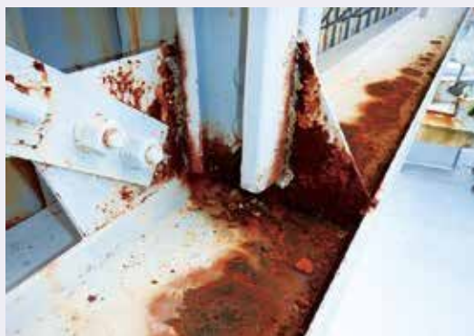
支柱・広告板接合部
