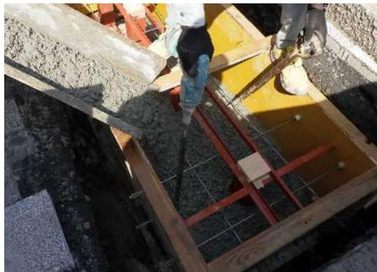
JISに基づき調合されたコンクリートの搬入とコンクリートの打込み
