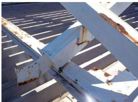
A-1 支柱 鉄骨構造部 A-2 支柱 広告板接合部
