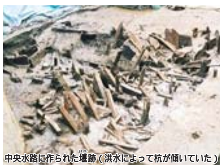
中央水路に作られた堰跡(洪水によって杭が傾いていた)
