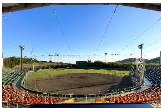
【静岡市プロスポーツチーム等連携プロジェクト】 清水庵原球場の改修に活用しました。
