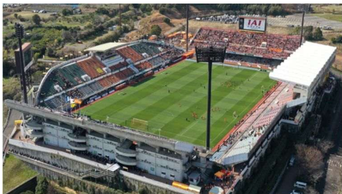
【静岡市プロスポーツチーム等連携プロジェクト】 清水日本平運動公園球技場の改修に活用しました。
