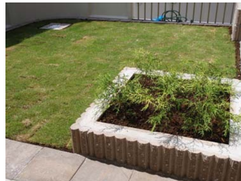
屋上緑化施工例
