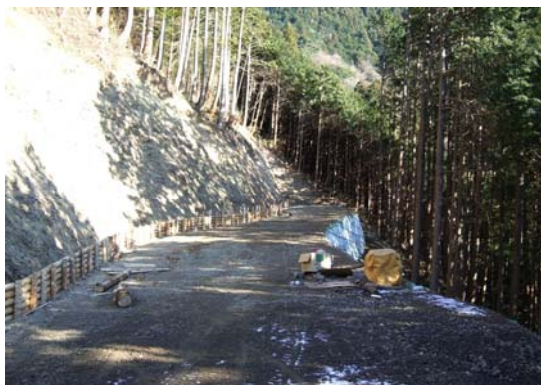
林道八重枯線(葵区大間)
