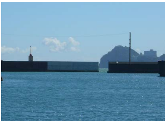
沖西防波堤平成23年度施工箇所
