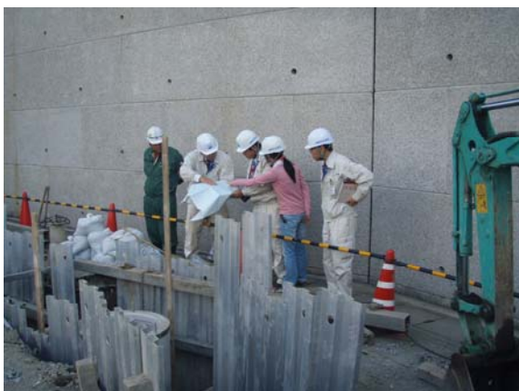
下水道開削工事現場視察
