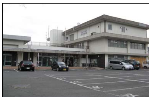
旧 西部生涯学習センター
