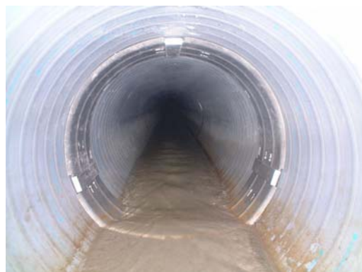
耐震補強した下水道管(施工事例)
