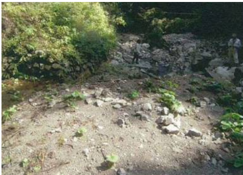
農地(わさび田)の被災状況
