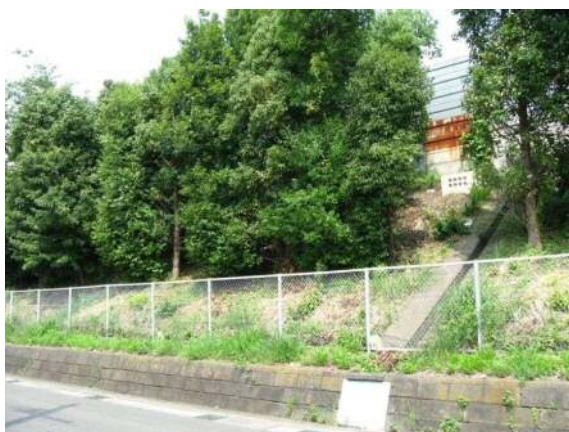
東名高速道路法面の状況
