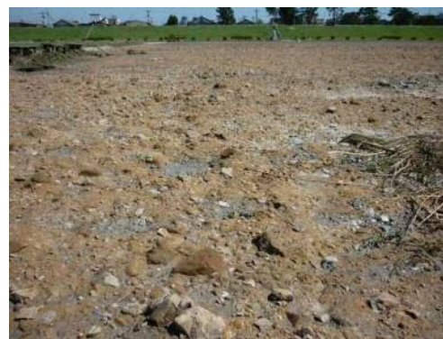
安倍川河川敷スポーツ広場(田町)の被災状況
