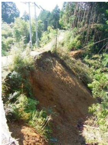
清水区布沢の被災状況
