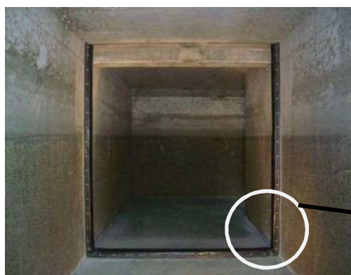
場内管渠への伸縮性継手の設置
