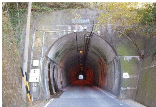
新吉原トンネル
