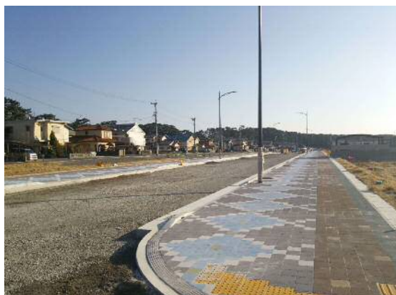
(都) 塚間羽衣線(工事中)
