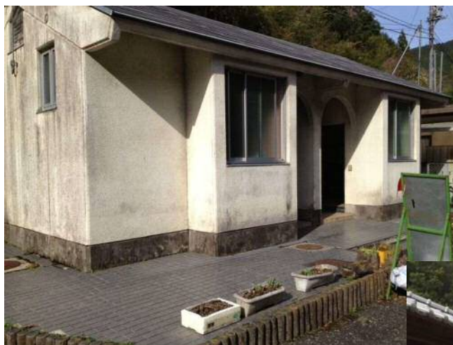
横沢観光公衆トイレ（現況）
