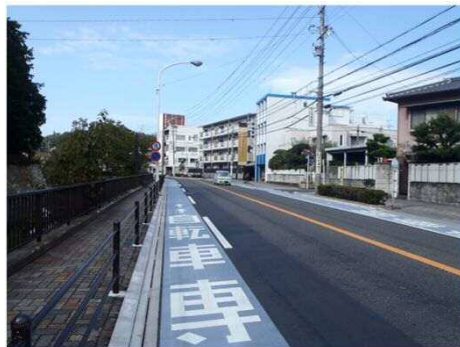
ハードインフラ: 自転車道ネットワーク整備
