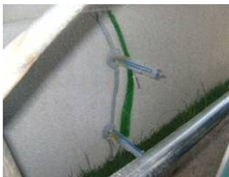
外壁改修工事中
