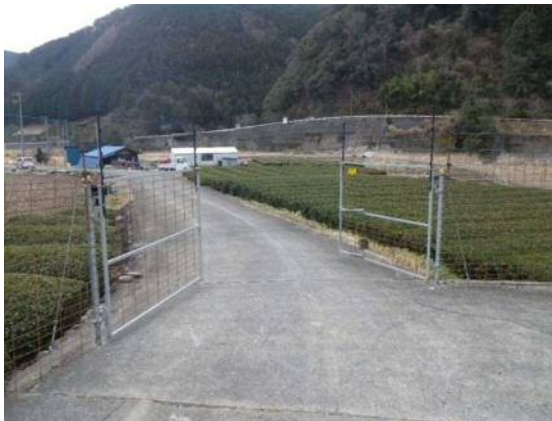
地域一体型大規模防護柵の例 ↑
