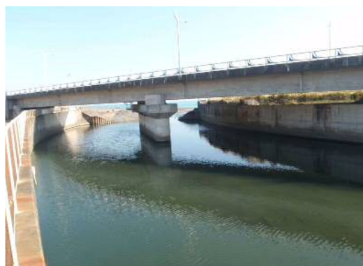
河口護岸(特殊堤防)
