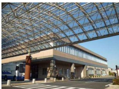
設置場所(城東保健福祉エリア保健所棟)
