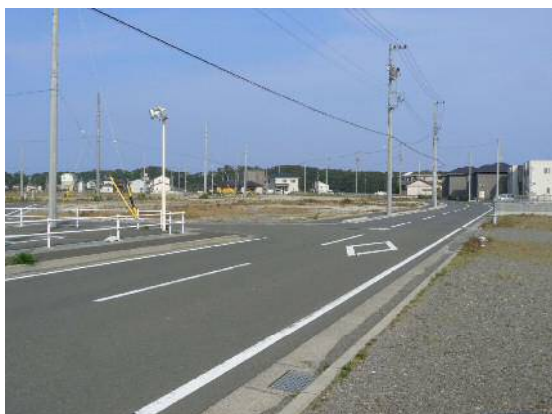
新設の区画道路
