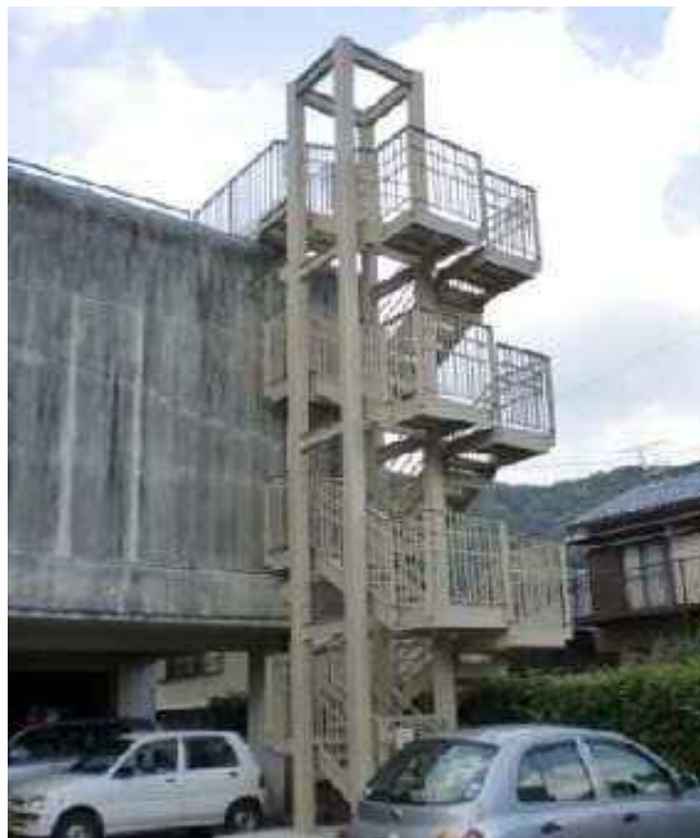
津波避難階段設置事例：三重県紀北町
