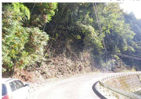
山側からの落石が懸念される箇所の例
