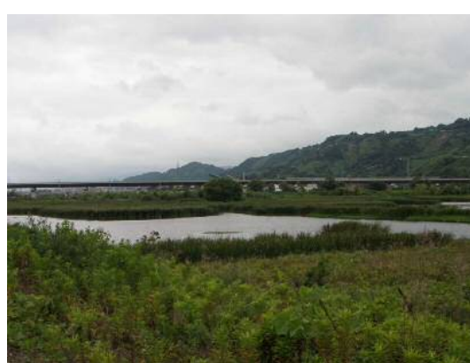
第1工区の現況
