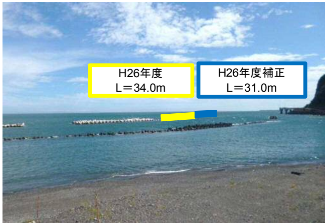
用宗沖離岸堤(駿河区石部)
