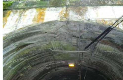
トンネル本体にひび割れが生じている箇所例
