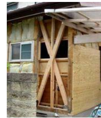
木造住宅の耐震補強
