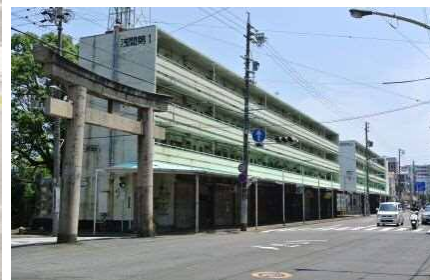
浅間団地(解体前)
