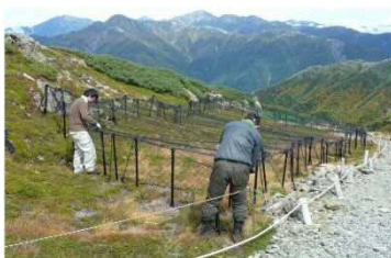
防鹿柵設置（中岳避難小屋周辺）
