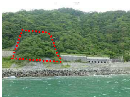
海岸沿いの浸食・風化した法面の崩壊を防止するため、法面崩壊対策を実施する
