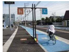
交通安全施設整備事業(自転車走行空間ネットワーク整備事業) (建設局)【237,000千円】
