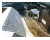
急傾斜地崩壊対策事業 (建設局)【18,000千円】
