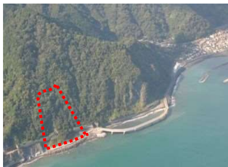
(県) 静岡焼津線(駿河区石部) 海岸沿いの浸食・風化した法面の崩壊を防止するため、法面崩壊対策を実施する。
