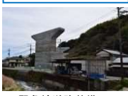
緊急輸送路整備 (主)清水富士宮線ほか (建設局)【1,825,400千円】
