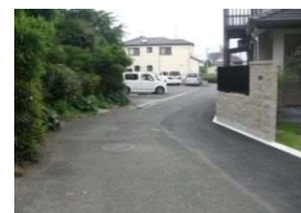
狭あい道路拡幅整備事業 実施後
