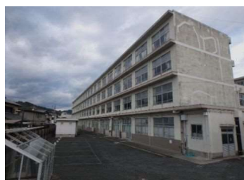
校舎改修前(例)
