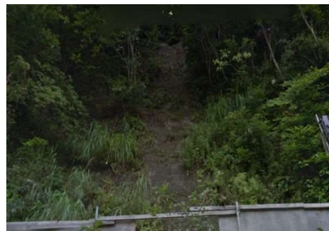
寺田線(清水区蒲原神沢) 過去の降雨により崩壊した法面の拡大を防止するため、法面崩壊対策を実施する。
