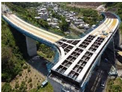
(主)清水富士宮線(庵原～伊佐布)の工事状況
