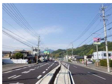
街路整備事業(静岡駅賤機線)
