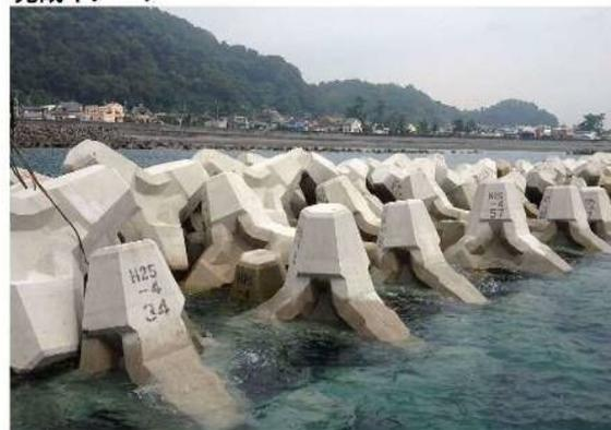
完成した消波ブロック構造の離岸堤
