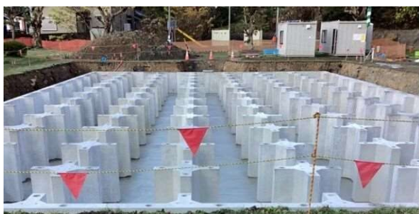
巴川流域治水対策事業 雨水貯留施設の工事の様子
