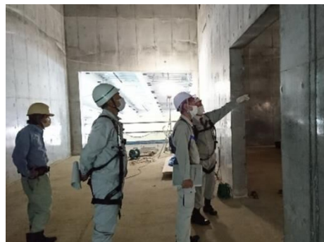
仮称静岡市歴史文化施設建築工事
