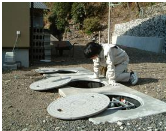
市による浄化槽立入検査
