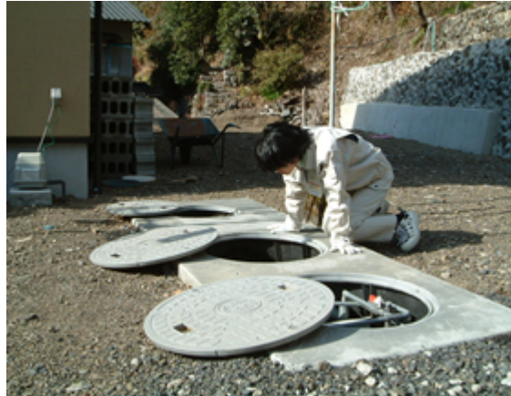
市による浄化槽立入検査
