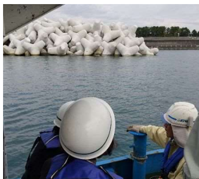
用宗漁港広野防波堤災害復旧工事
