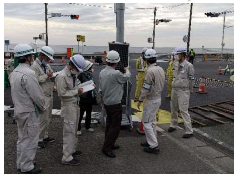
(国) 150号久能拡幅(根古屋)道路改良工事
