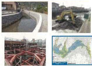
河川改修・下水道施設整備 (建設局)【136,000千円】 上下水道局【3,880,911千円】
