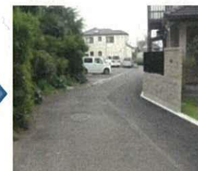
狭あい道路拡幅整備事業 実施後
