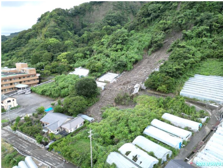
駿河区根古屋の崩土
