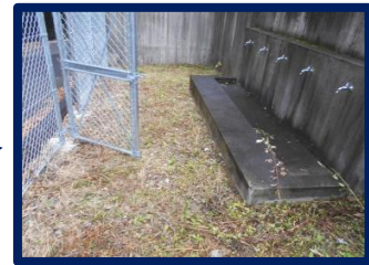
配水池に設置した給水栓事例
