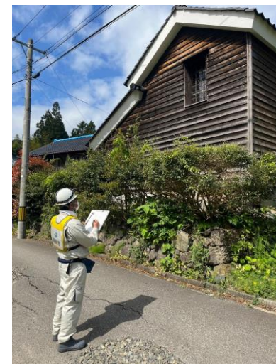
住家被害認定調査
