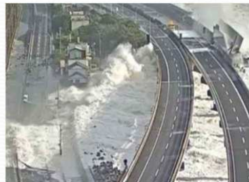
高潮被害による通行止め状況
