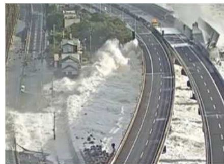
平成29年10月の高潮被害
