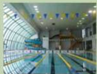
静岡市西ヶ谷 総合運動場 (屋内プール) へ熱供給
