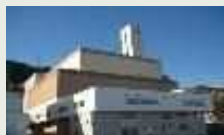
西ヶ谷清掃工場
