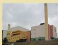
清掃工場内の 給湯
