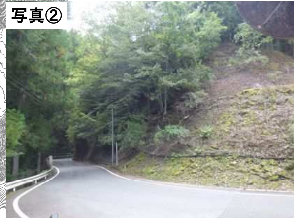
(主) 南アルプス公園線
