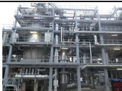
③焼却炉 ④熱交換器 (経過年数27年) (経過年数9年)
