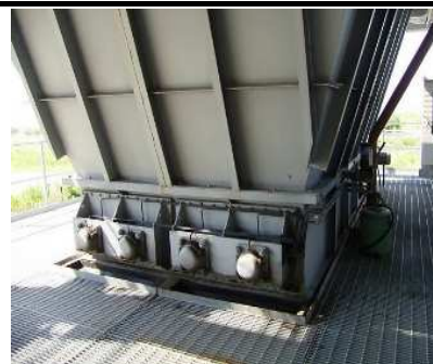
①脱水汚泥貯留装置 (経過年数25年)
