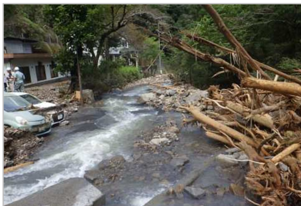
豪雨時に荒廃人工林が崩れ樹木が流出し河川をふさいだ結果あふれた水と土砂により人家や車両に被害が生じた例
