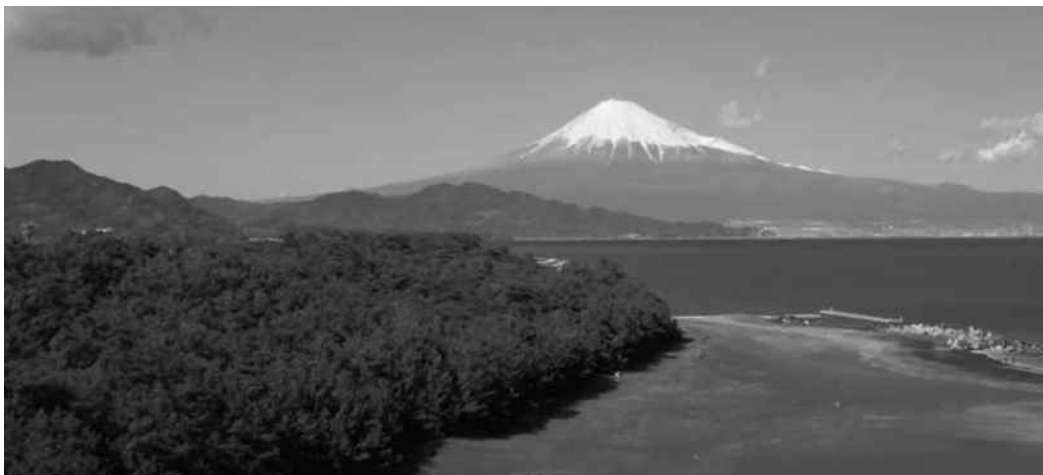
突堤（1号突堤、写真奥）と、撤去前の消波ブロック（1号消波堤、写真手前）
