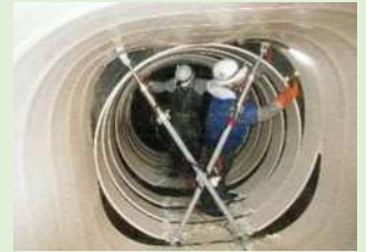
耐震化施工中の下水道管
