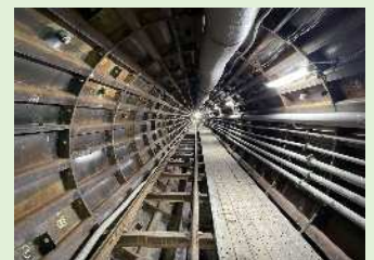
大沢雨水1号幹線（工事中）
