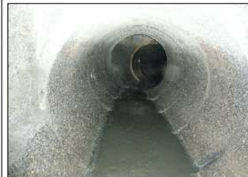
管の耐震化施工前
