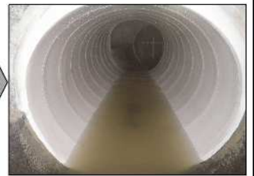
管の耐震化施工後
