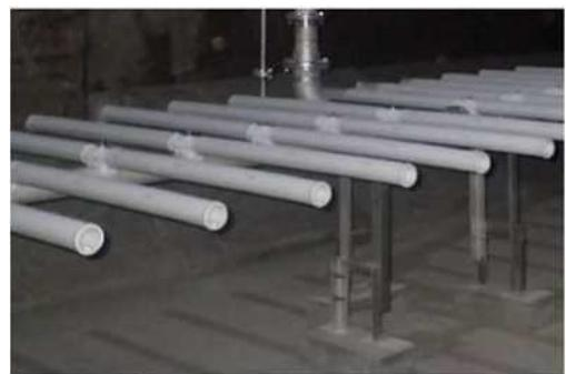
省エネ設備の一例（散気板を高効率型への更新）
