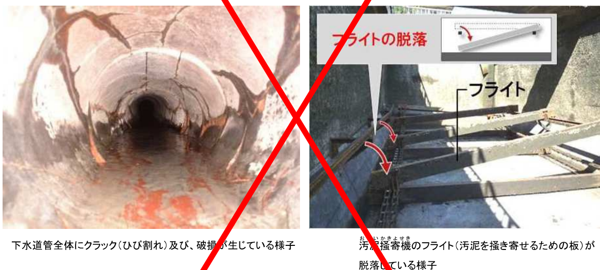
図 3-8 老朽化した下水道管や施設
