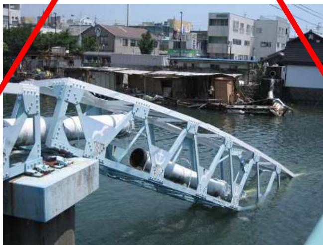
図 3-6 老朽化し破損した水道管
