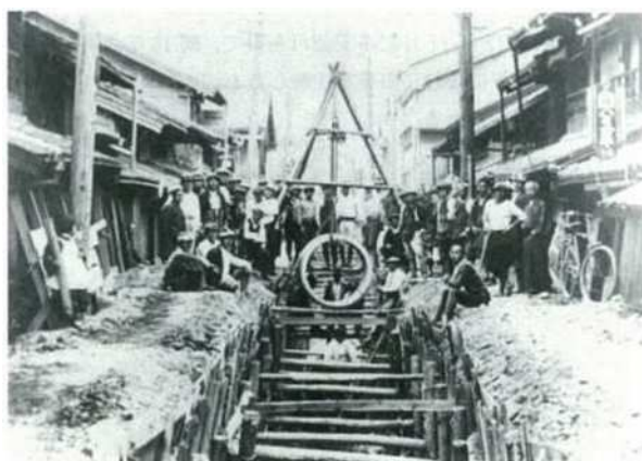
図 2-4 当初の下水道管布設風景
