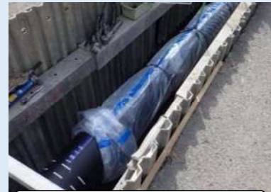
耐震化された水道管への布設替
