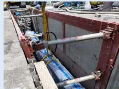
老朽化した水道管の布設替
