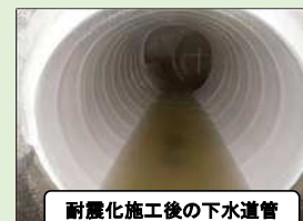
耐震化施工後の下水道管
