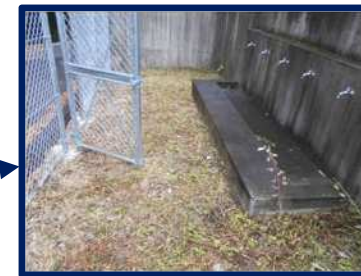
配水池に設置した給水栓事例
