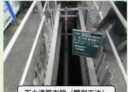
下水道管布設（開削工法）
