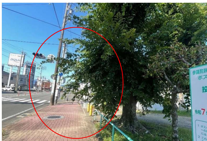
【写真 15：枝葉が建築限界を侵している状況】
