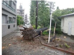
強風で敷地境界付近の樹木が 根本から倒木し、電線引込柱を損傷
