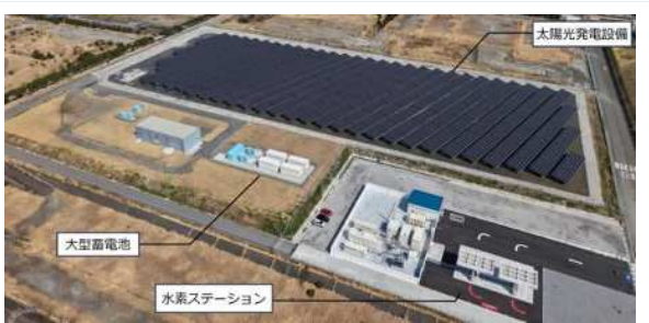
グリーン水素を用いた清水水素ステーション(清水区) 出典: ENEOS Power株式会社
