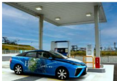
静岡清水水素ステーション 令和7年3月竣工
