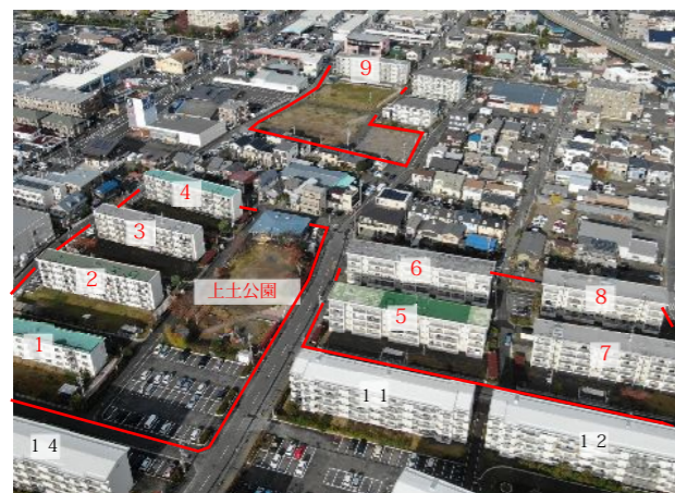
上土団地 上空写真
