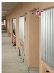
共用廊下側の窓面格子
